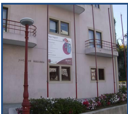
Cartaz da Campanha na fachada da Junta de Freguesia de Rebordosa
